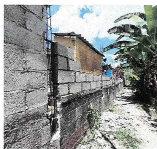
Foto 3: 27 metros lineales X 1.50 metros de altura
