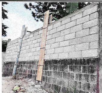
Foto 1: 6.70 metros lineales X 1.50 metros de altura
