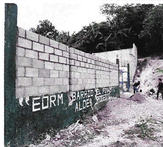
Foto 4: 10.60 metros lineales X 1.50 metros de altura
