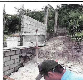
Foto 2: 6.50 metros lineales X 1,50 metros de altura
