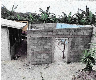
Foto 5: 3.80 metros lineales X 2.50 metros de altura
