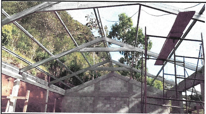
Foto 4: Sustitución de techo
