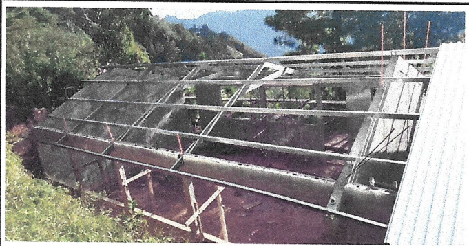
Foto 5: Sustitución de techo
