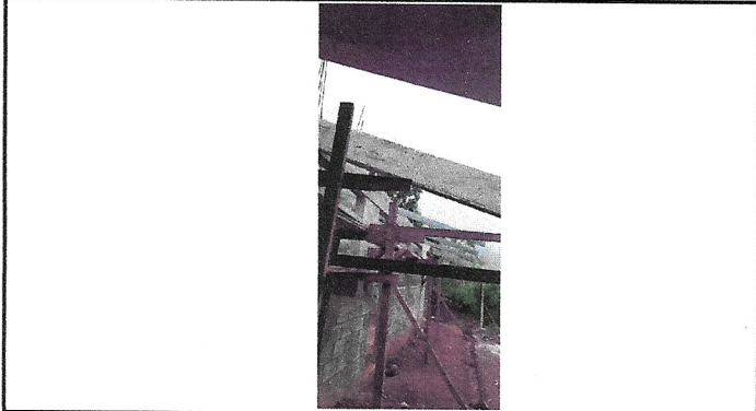
Foto1: Sustitución de techo
