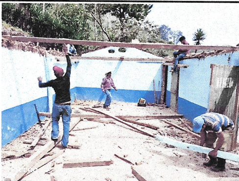
Foto 4: Sustitución de estructura de madera por metal
