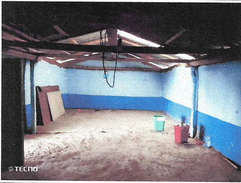
Foto 3: Sustitución de piso cerámico
