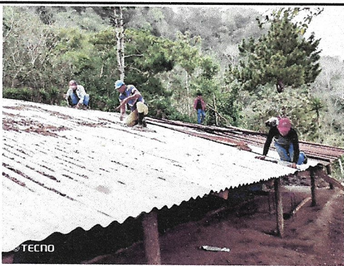
Foto 2: Sustitución de lámina
