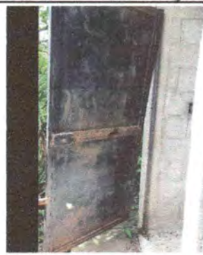
Foto 2: Sustitución de puerta
