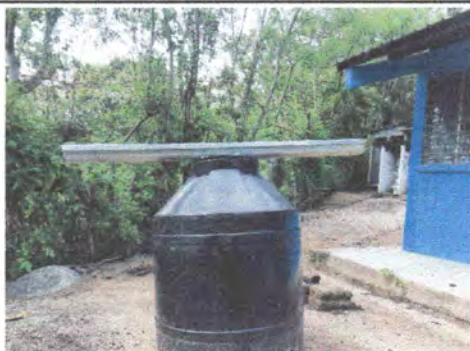
Foto 5: Sustitución de tinaco
