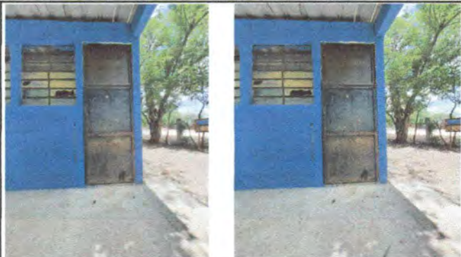
Foto1: Reparación, mantenimiento y pintura de puertas.
