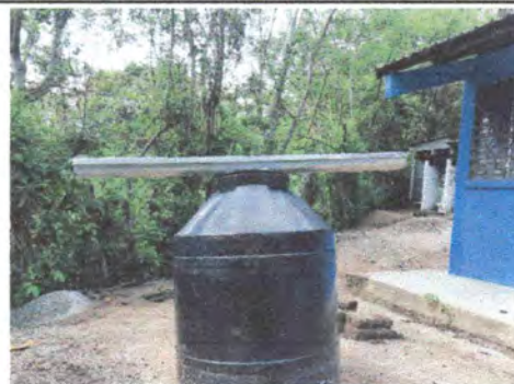
Foto 6: Sustitución de canal de bajada de agua
