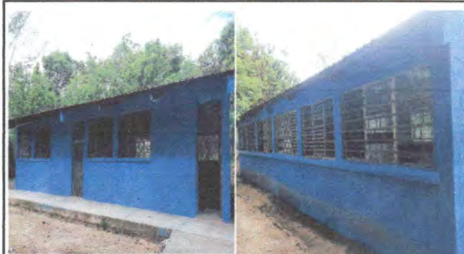
Foto 4: Fabricación de ventanas de PVC
