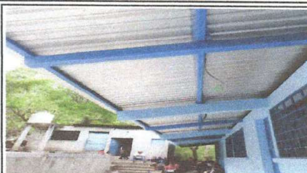
Foto 2: Sustitución de capote de lámina para lámina troquelada mantenimiento de estructura de sopore de metal
