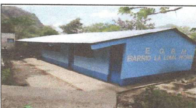
Foto 6: Sustitución de lámina por lámina troquelada
