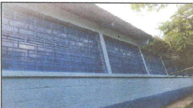
Foto 3: sustitución de estructura de metal de ventana
