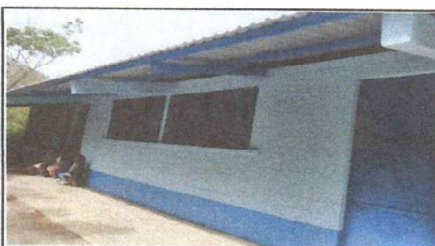
Foto 4: Sustitución de estructura de metal de ventana
