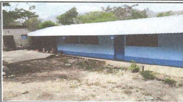
Foto1: Sustitución de lámina por áminas troquelada, aluxinc
