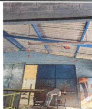
Foto 2: Sustitución de capote de lámina para lámina troquelada mantenimiento de estructura de sopore de metal
