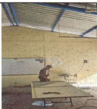
Foto 5: Sustitución de estructura de metal de ventana
