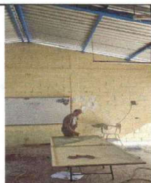
Foto 3: sustitución de estructura de metal de ventana
