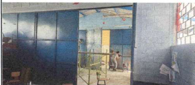
Foto 4: Sustitución de estructura de metal de ventana
