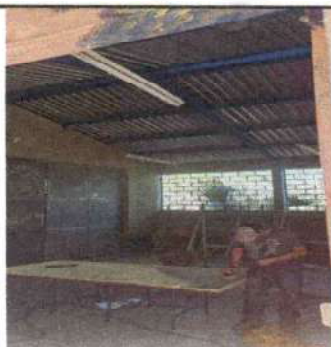
Foto 6: Sustitución de lámina por lámina troquelada
