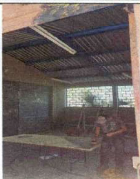
Foto1: Sustitución de lámina por áminas troquelada, aluxinc
