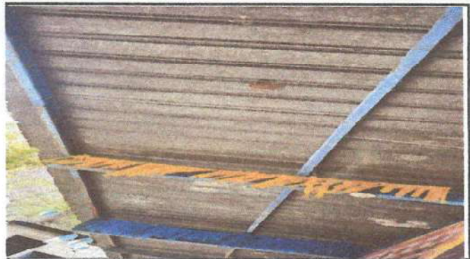
Foto 2: Sustitución de capote de lámina para lámina troquelada mantenimiento de estructura de sopore de metal
