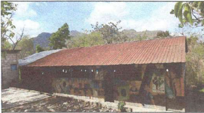
Foto1: Sustitución de lámina por áminas troquelada, aluxinc
