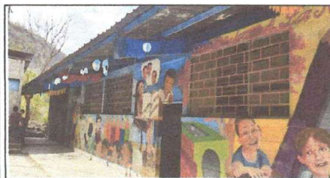
Foto 5: Sustitución de estructura de metal de ventana
