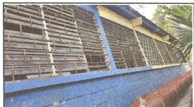
Foto 4: Sustitución de estructura de metal de ventana
