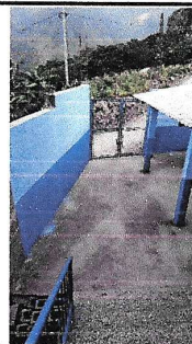
Foto 6: estado actual losa de patio
