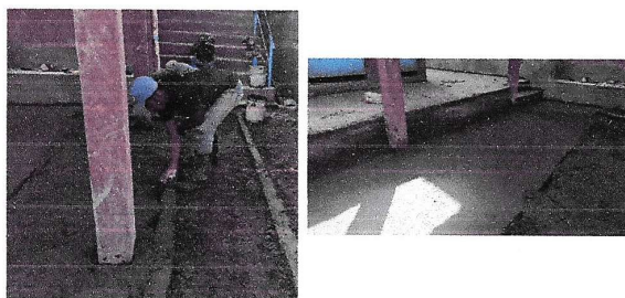
Foto 3: Reparacion losa de Patio
