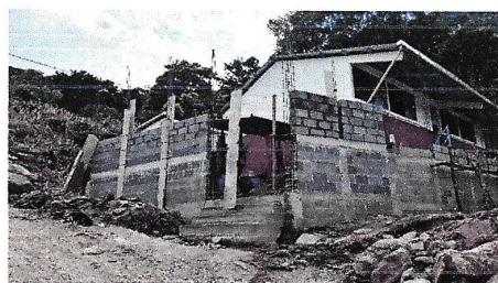
Foto 4: Seguimiento muro perimetral
