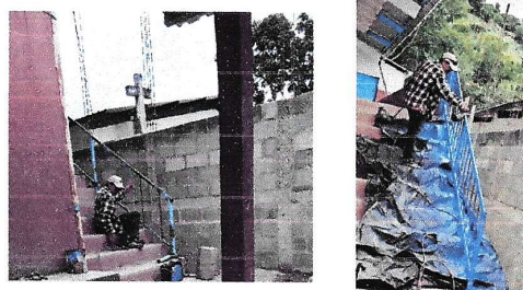
Foto 2: Reparacion de Varanda
