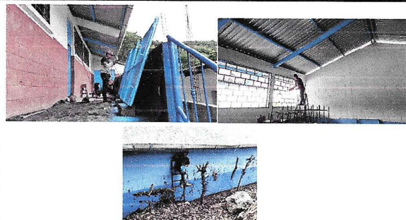
Foto1: Pintura Interios exterior de escuela
