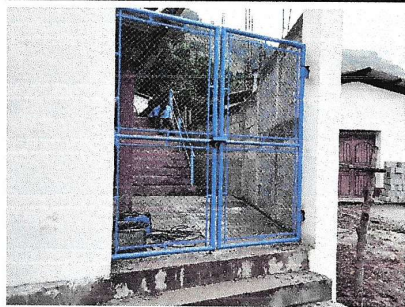
Foto 5: Instalacion de porton
