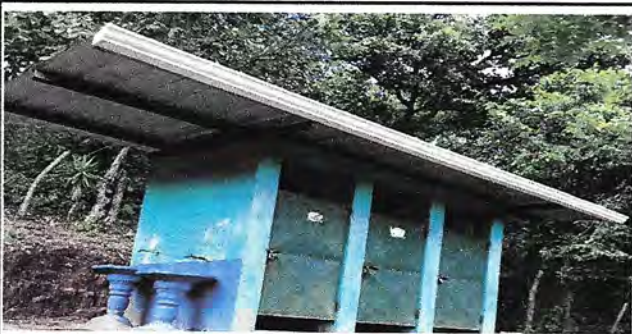
Foto 5: PINTURA DE BAÑOS Y LAVAMANOS
