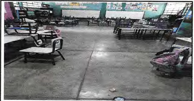
Foto 4: CAMBIO DE TORTA DE CEMENTO POR PISO CERÁMICO
