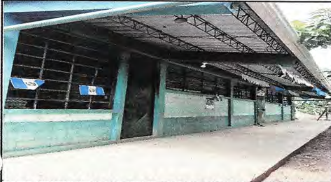
Foto1: CAMBIO DE VENTANALES POR VENTANAS PVC CORREDIZAS MANTENIMIENTO A BALCONES
