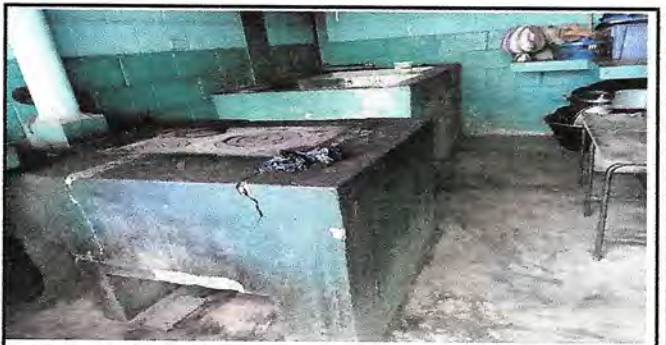
Foto 6: REPARACION Y SUSTITUCION DE PLANCHA LORENA
