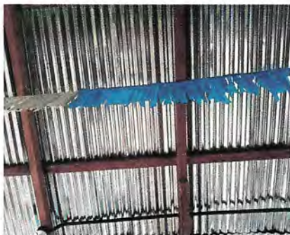
Foto 5: remozamiento de estrucuta de techo y cubierta de lamina
