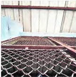
Foto1: remozamiento en cubierta de lamina y estructura de techo
