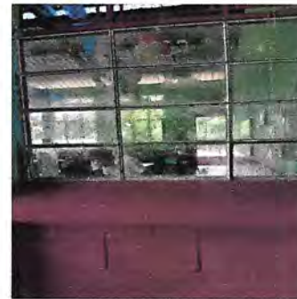
Foto 4: Quitar ventanas y colocar ventanas corredizas de metal
