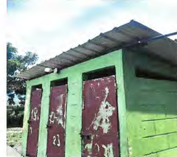
Foto 2: refuerzo de base de instalación de un Rotoplast para uso de baños y pinturas para las puertas de baño
