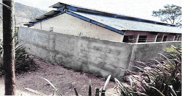
Foto1: Muro perimetral ya finalizado el la parte lateral y la parte de atrás del centro educativo.
