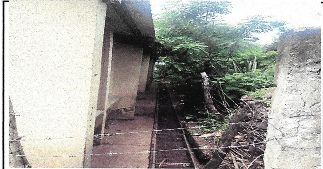
Foto1: De esta forma estan las bases del muro anterior
