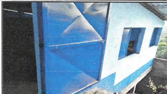
Foto1: Sustrución de puerta de lámina por metal
