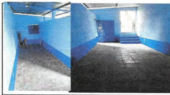
Foto 5: Reparación de muro y repello
