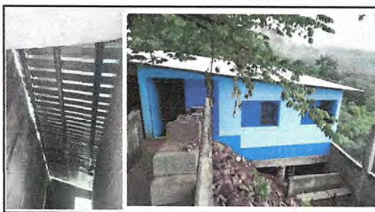
Foto 4: canales y bajadas de agua pluvial y cuneta y banquetta de concreto
