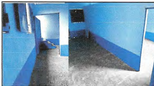
Foto 3: Sustrución de piso de cemento por piso de granito
