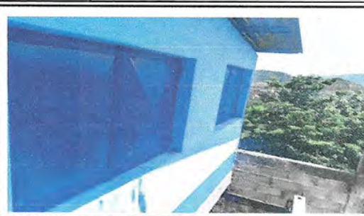
Foto 2: Sustrución de Ventanas
