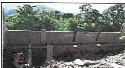
Foto 6: Reparación de muro de contención
