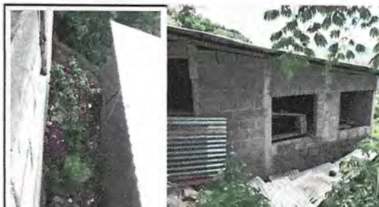
Foto 4: canales y bajadas de agua pluvial y cuneta y banquetta de concreto
