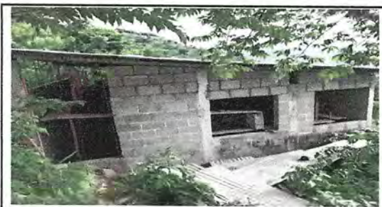
Foto 5: Reparación de muro y repello
