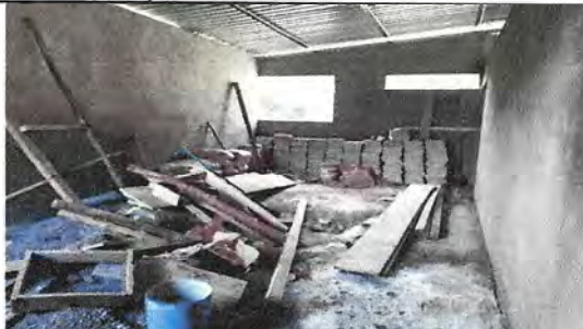
Foto 2: Sustrucción de Ventanas
