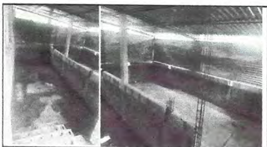
Foto 5: Reparación de muro y repello
