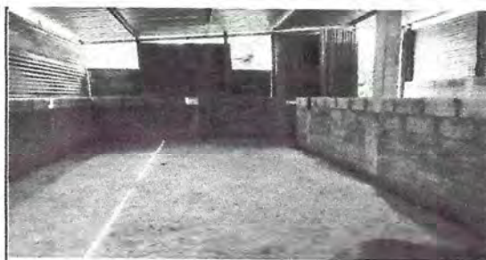
Foto 3: Sustrución de piso de cemento por piso de granito
