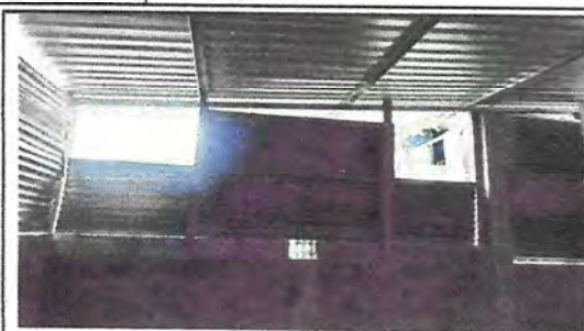
Foto 2: Sustrución de Ventanas
