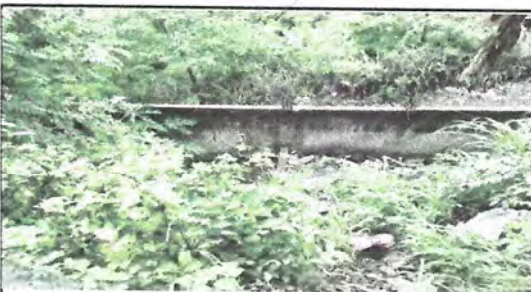
Foto 6: Reparación de muro de contención
