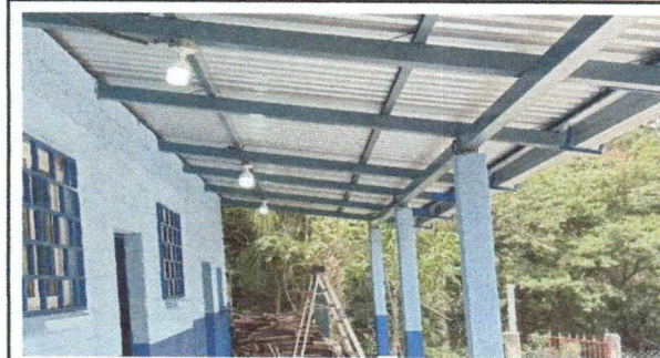
Foto 4: PINTURA EN MUROS INTERIORES Y EXTERIORES
