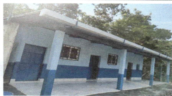
Foto 3: COLOCAR CANALES Y BAJADAS DE AGUA
