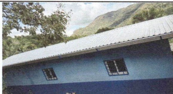
Foto1: ESTRUCTURA DE TECHO
