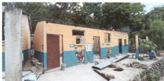
Foto 1: ESTRUCTURA DE TECHO
