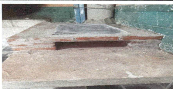
Foto 5: SUSTITUCIÓN DE ESTUFA RURAL COMPLETA
