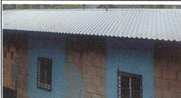
Foto 4: PINTURA EN MUROS INTERIORES Y EXTERIORES
