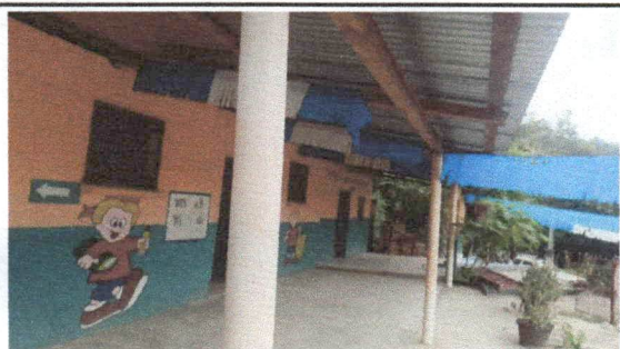
Foto 3: COLOCAR CANALES Y BAJADAS DE AGUA
