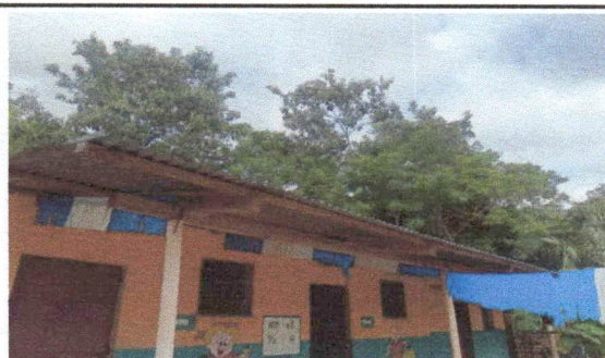
Foto 4: PINTURA EN MUROS INTERIORES Y EXTERIORES
