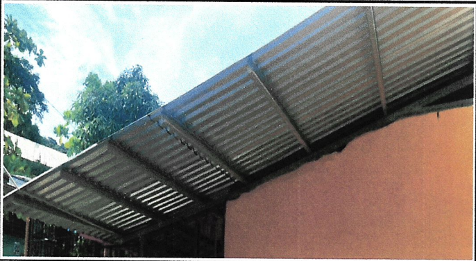
Foto1: CUBIERTA DE TECHO
