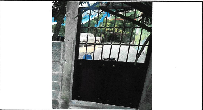
Foto 3: REPARACION DE PUERTA DE ACCESO
