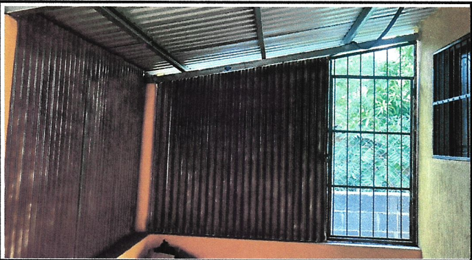
Foto 8: INSTALACIÓN DE VENTANA
