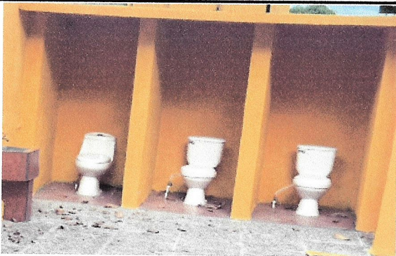
Foto 4: REPARACION DE SERVICIOS SANITARIOS
