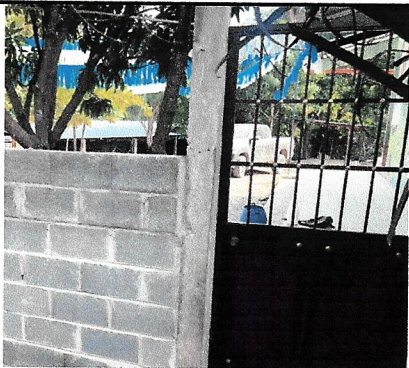
Foto 3: REPARACION DE PUERTA DE ACCESO
