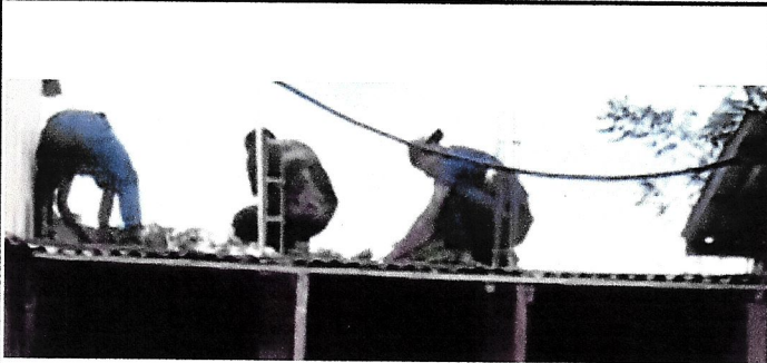
Foto1: CUBIERTA DE TECHO EN MAL ESTADO
