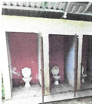
Foto 4: REPARACION DE SERVICIOS SANITARIOS
