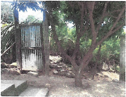
Foto 3: REPARACION DE PUERTA DE ACCESO
