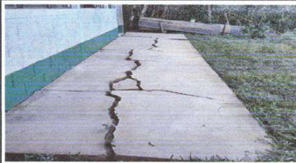
Foto 4: losa de patio
