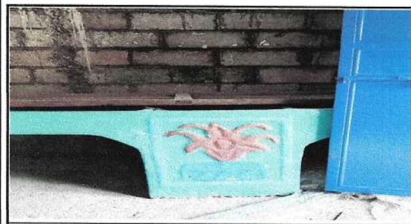
Foto 5: Pila de dos lavaderos
