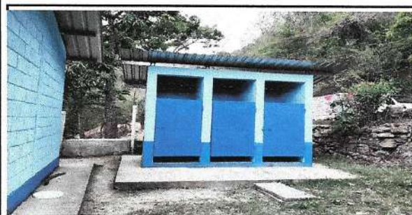
Foto 3: Alijado y pintado de puertas, sustitución de techo, instalación de sanitarios y piso cerámico
