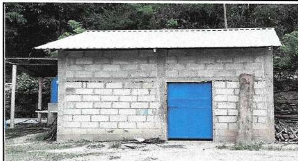
Foto 2 Cubierta de lámina y continuación de 3 hiladas de block y cambio de puerta metálica.
