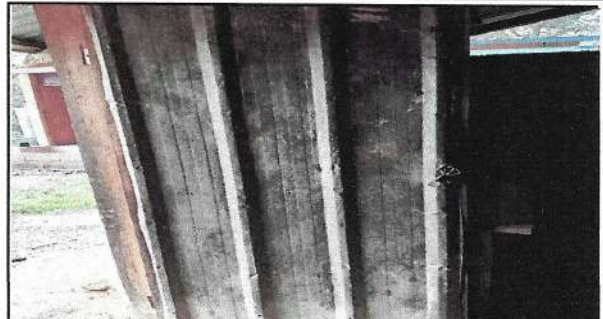
Foto 2 Sustitución de puerta de lámina por puerta de metal
