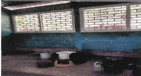
Foto1: Pintura en paredes, puertas y colocacion de ventanas corredizas
