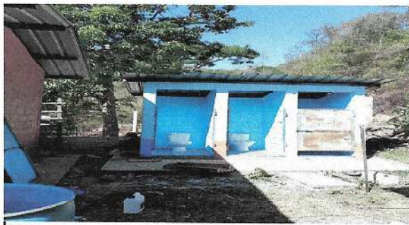
Foto 3: Alijado y pintado de puertas, sustitución de techo, colocación de sanitarios y piso cerámico
