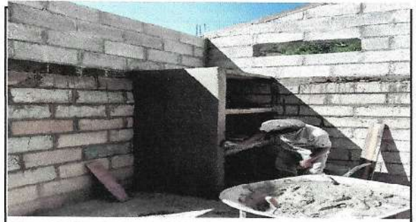
Foto 6: Sustitución de mesa de tablas por gabinete
