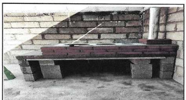
Foto 4: Sustitución de polleton por estufa de 3 hornillas y piso de cemento.
