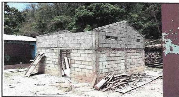
Foto 5: Compra de pila y 3 hiladas de block en altura y estructura de techo.
