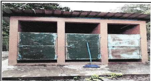
Foto 3: Alijado y pintado de puertas, sustitución de techo, colocación de sanitarios y piso cerámico
