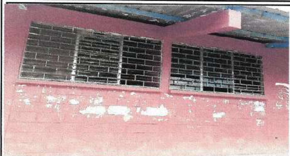
Foto 1: Pintura en paredes, puertas y colocación de ventanas corredizas
