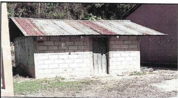
Foto 5: Compra de pila y 3 hiladas de block en altura.
