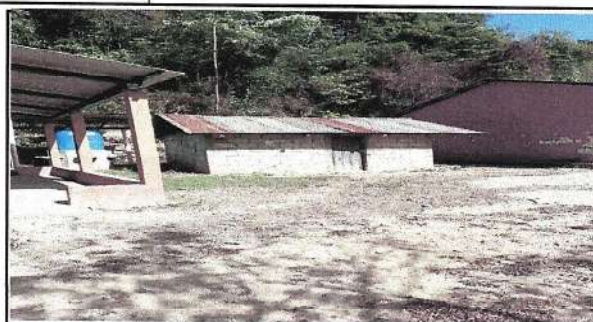
Foto 2 Sustitución de puerta de lámina por puerta de metal y estructura de techo.
