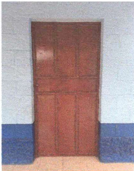
Foto1: Mantenimiento de puertas
