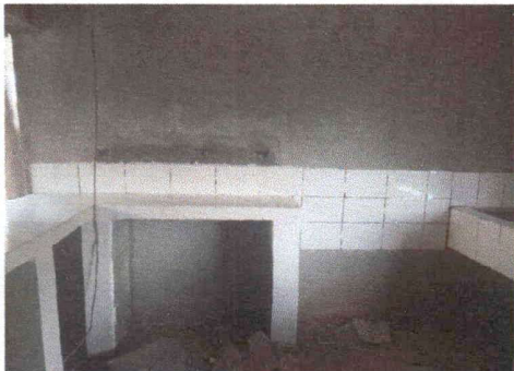
Foto 3: Repello en muro de cocina
