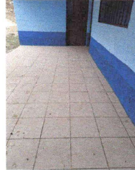
Foto 2: Sustitución de piso cerámico
