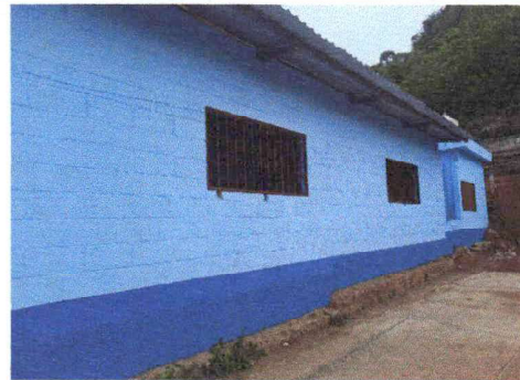
Foto 4: Mantenimiento de ventanas
