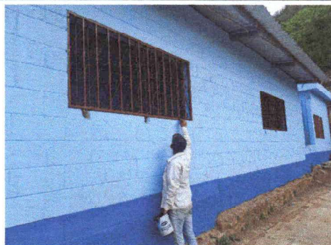
Foto 4: Mantenimiento de ventanas
