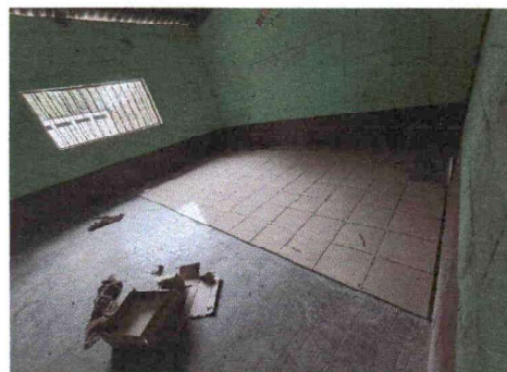
Foto 2: Sustitución de piso cerámico
