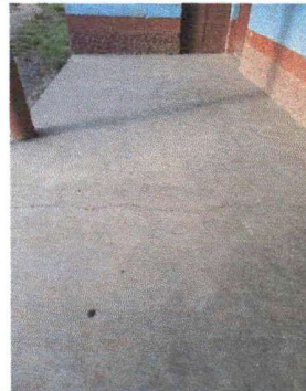
Foto 2: Sustitución de piso cerámico
