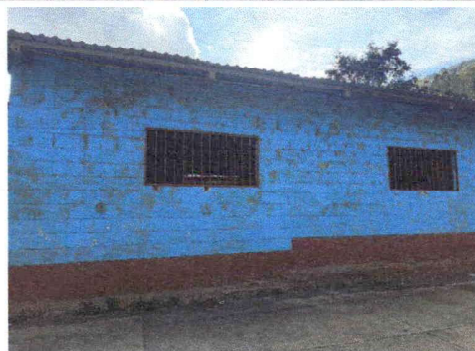
Foto 4: Mantenimiento de ventanas
