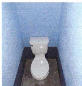
Foto 3: Cambio de servicios sanitario
