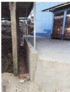
Foto1: Sustitución de muro de contención
