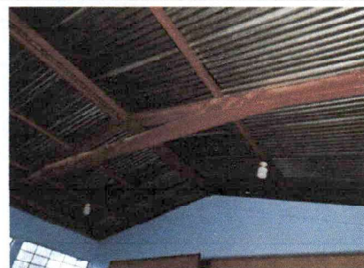
Foto 4: Sustitución de instalación eléctrica
