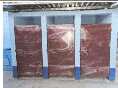
Foto 6: Sustitución de puertas
