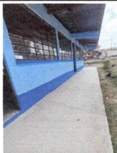
Foto 5: Pintura de exterior e interior del establecimiento
