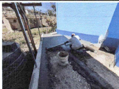
Foto 6: Sustitución de piso de concreto
