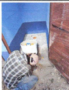
Foto 3: Cambio de servicios sanitario
