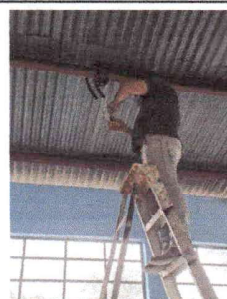
Foto 4: Sustitución de instalación eléctrica
