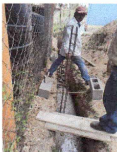
Foto 1: Sustitución de muro de contención
