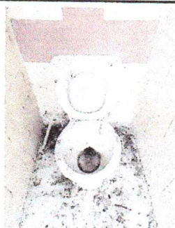
Foto 3: Cambio de servicios sanitario
