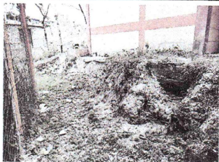
Foto 1: Sustitución de muro de contención
