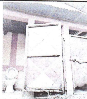
Foto 6: Sustitución de puertas
