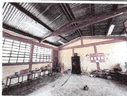
Foto 4: Sustitución de instalación eléctrica
