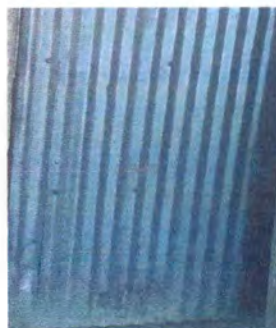
sustitucion de puerta de lamina por puerta de metal
