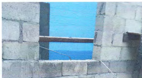
sustitucion de ventana por ventana de metal
