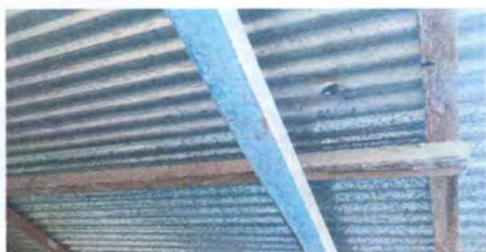
Foto1: sustitucion de lamina por lamina troquelada
