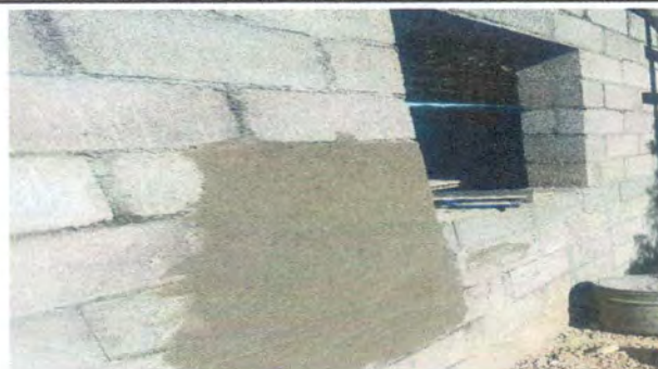
Foto 6: reparacion de repello en paredes
