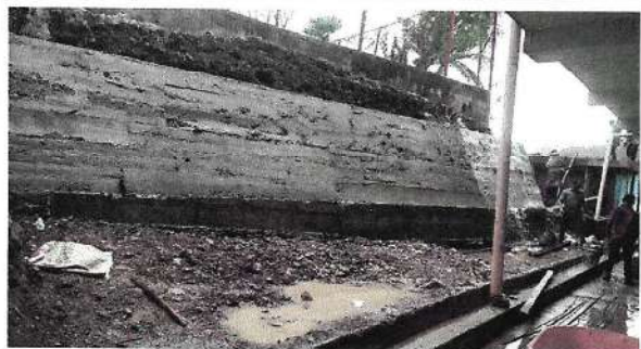
Foto 1: Seguimiento de muro de contención
