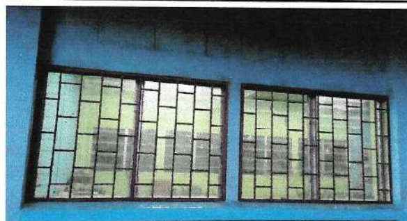
Foto 4: Mantenimiento de ventanas
