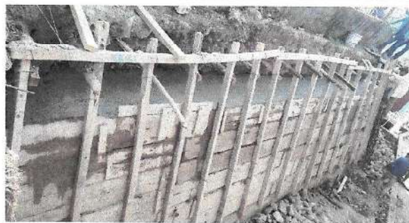
Foto 1: Seguimiento de muro de contención
