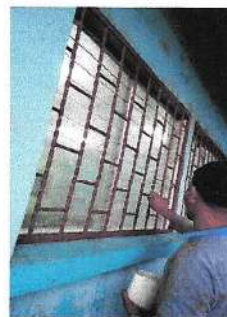
Foto 4: Mantenimiento de ventanas
