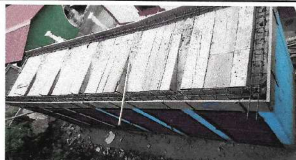
Foto 6: Cambio de cubierta metálica
