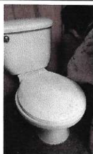
Foto 3: Cambio de servicios sanitario
