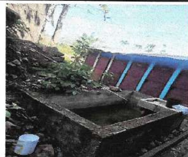
Foto 2: Repello y Alisado en muro
