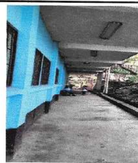
Foto 4: Mantenimiento de ventanas
