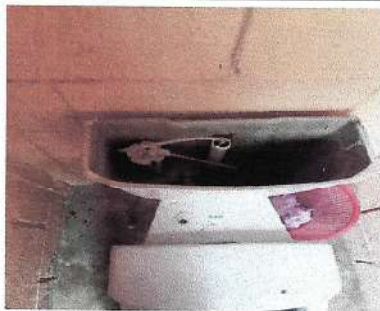
Foto 3: Cambio de servicios sanitario
