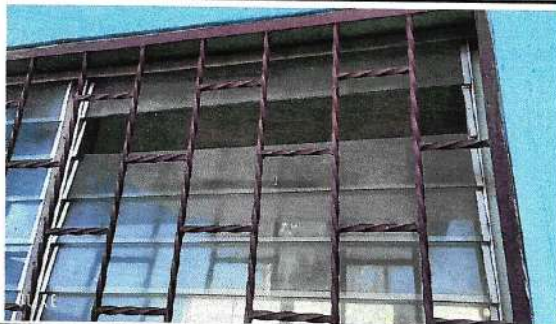
Foto 5: Cambio de vidrio
