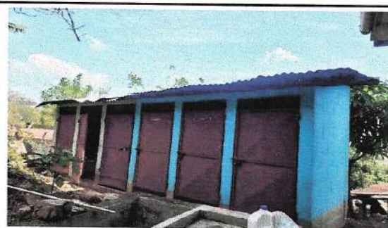
Foto 6: Cambio de cubierta metálica
