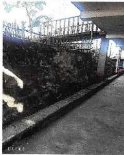
Foto 1: Seguimiento de muro de contención
