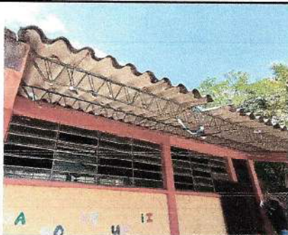
ESTRUCTURA DE SOPORTE DE TECHO
