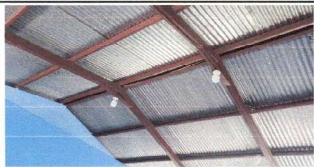
Reparación de cableado eléctrico
