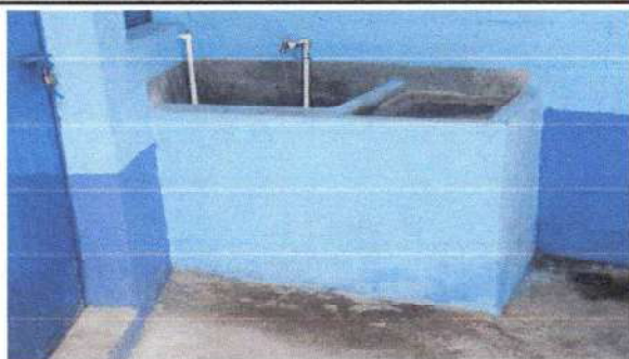
Extra sustitución de pila pvc por block
