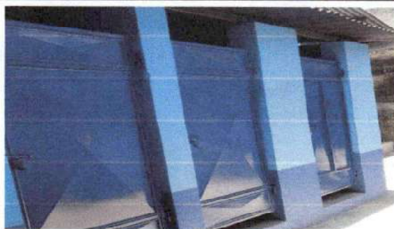
Mantenimiento de Estructura, lijado y aplicación de pintura en puertas
