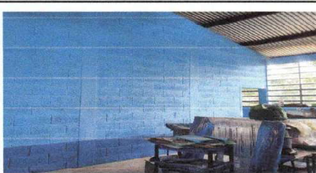
Extra pintura en muros interiores
