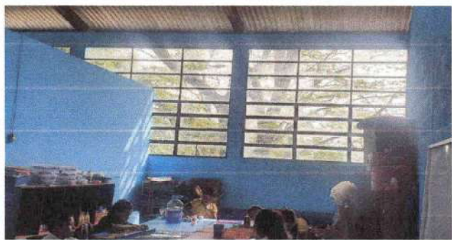
Sustitución de 15 vidrios en ventanas
