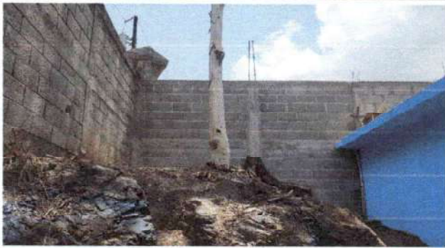
Reparación de serco de malla por muro perimetral de block
