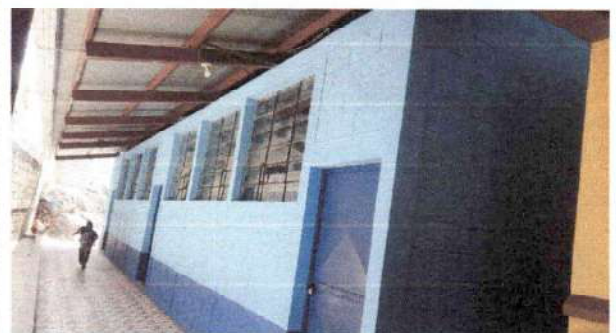
Pintura en muros exteriores
