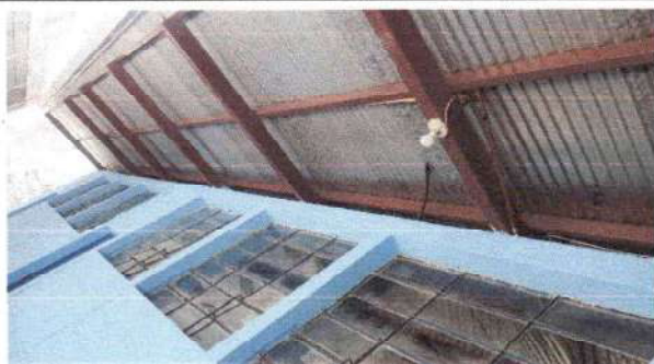
Reparación de cableado eléctrico
