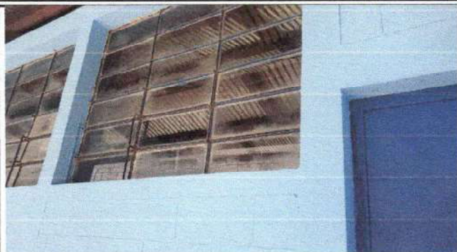
Sustitución de 15 vidrios en ventanas
