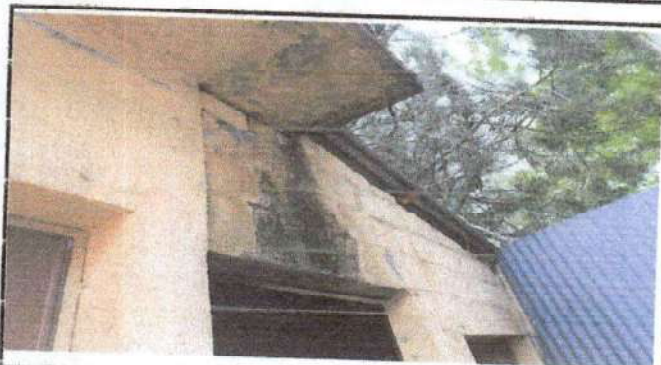
Reparación de muro perimetral
