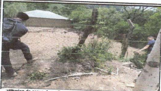
Sustitución de cerco de malla por muro perimetral de block con tubo hg y alia galvanizada
