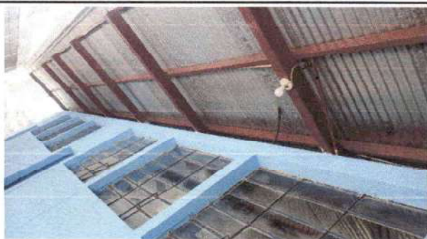
Reparación de cableado eléctrico
