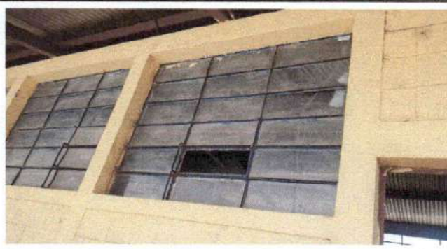
Sustitución de 15 vidrios en ventana
