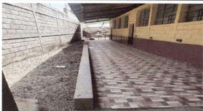
Reparación de 20 m2 de plancha de concreto en patio
