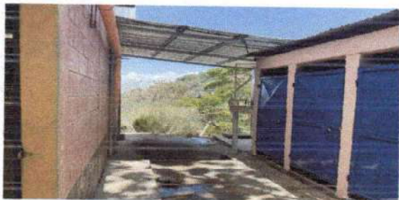
Foto 1: Instalacion de bajada de agua pluvial
