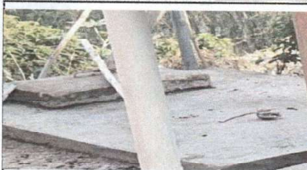
Foto 2: Caja de Registro
