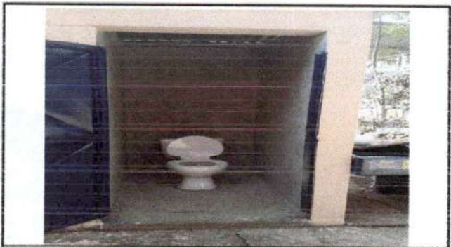
Foto 3: REPELLO DE PAREDES, CAMBIO DE ARTEFACTO SANITARIO
