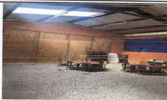
Foto 2: Instalacion de cinta tapagotera
