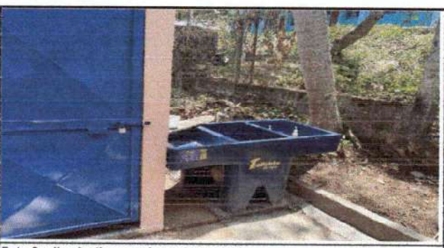
Foto 6: pila plastica mas base de concreto
