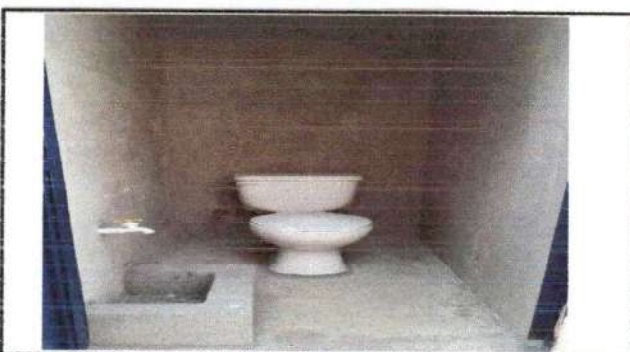
Foto 4: INSTALACION DE MINGITORIO
