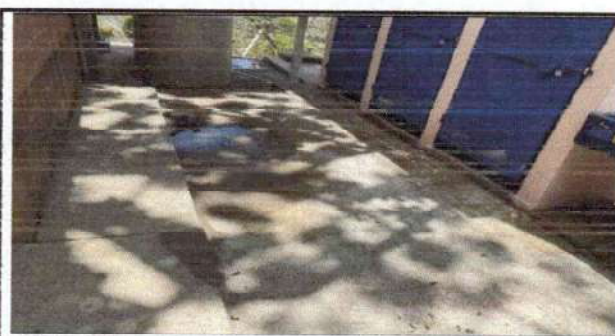
Foto 6: banqueta de concreto
