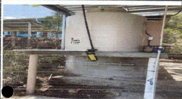
Foto 1: Instalación de Bomba de Agua de 1/2 caballo de fuerza
