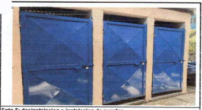
Foto 5: desinstalacion e instalacion de puertas
