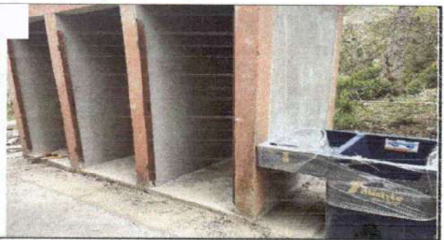
Foto 5: desinstalacion e instalacion de puertas
