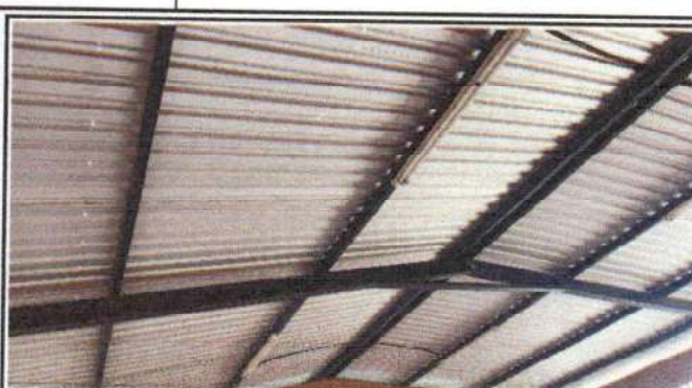
Foto 2: Instalacion de cinta tapagotera
