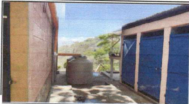
Foto 1: línea de conducción de agua pluvial(18m) mas bajada de agua pluvial, instalacion de bajada de agua pluvial.
