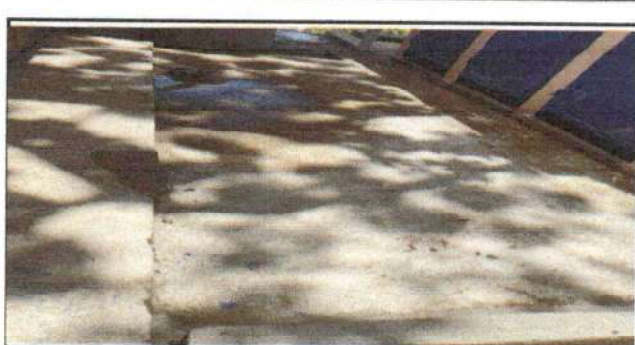
Foto 6: Banqueta de concreto
