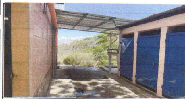
Foto 5: Estructura metalica para tinacos(2.56x6)+tinaco de 750 litros
