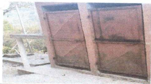
Foto 5: desinstalacion e instalacion de puertas
