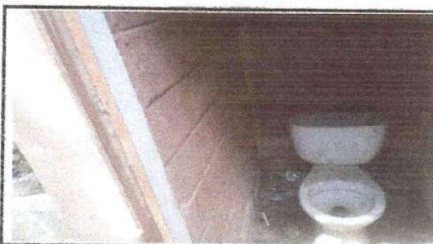
Foto 4: INSTALACION DE MINGITORIO
