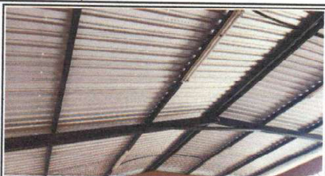
Foto 2: Instalacion de cinta tapagotera
