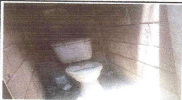
Foto 3: RÉPELLO DE PAREDES, CAMBIO DE ARTEFACTO SANITARIO
