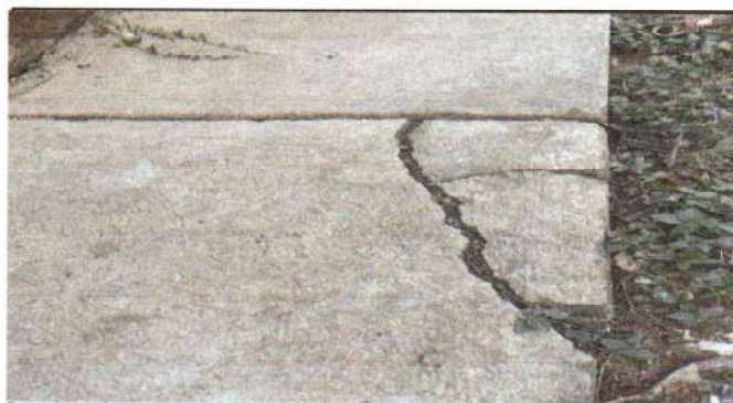
Foto 5: Banqueta de concreto
