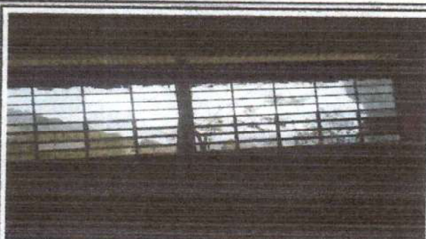
Foto 2: Desinstalacion e instalacion de ventana tipo V-3(140x1.30) Desinstalacion e instalacion de ventana tipo 4-(0.80x1.30)
