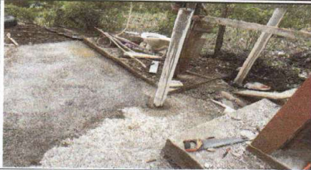
Foto 1: Instalacion de bajada de agua pluvial Linea de conducción de agua pluvial (18m)
