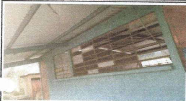
Foto 1: desinstalacion e instalacion de ventana tipo V-1(1.30x4.25) Desinstalacion e instalacion de ventana tipo V-2(5x1.30)
