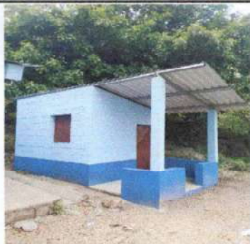
Foto 1: Cambio de cubierta metálica
