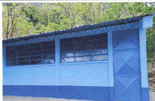
Foto 4: Mantenimiento de puertas y ventanas
