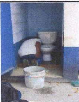
Foto 3: Cambio de servicios sanitarios
