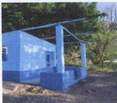
Foto 1: Cambio de cubierta metálica
