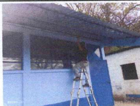
Foto 4: Mantenimiento de puertas y ventanas
