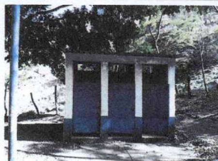
Foto 2: Cambio de cubierta metálica por losa de concreto armado
