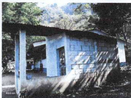
Foto 1: Cambio de cubierta metálica
