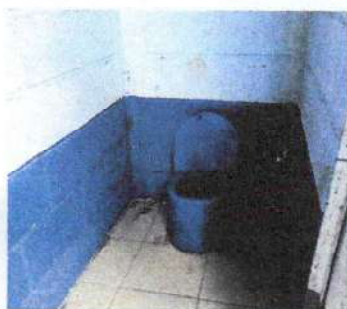
Foto 3: Cambio de servicios sanitario
