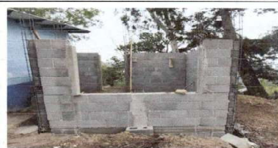
Foto 6: SEGUIMIENTO DE MURO
