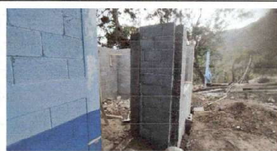
Foto 4: SEGUIMIENTO DE MURO
