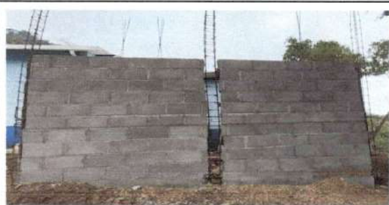
Foto 5: SEGUIMIENTO DE MURO
