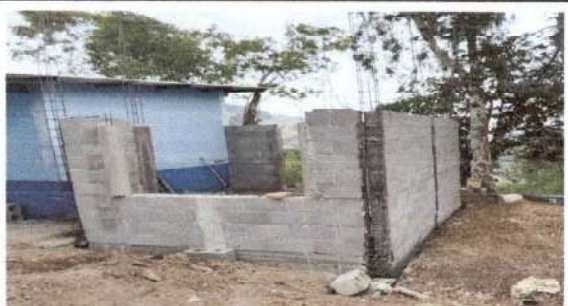
Foto 3: SEGUIMIENTO DE MURO
