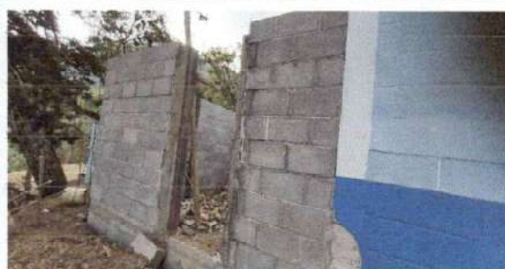
Foto 2: SEGUIMIENTO DE MURO
