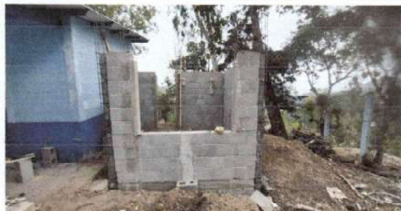
Foto 1: SEGUIMIENTO DE MURO
