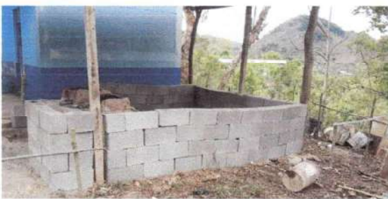
Foto 5: SEGUIMIENTO DE MURO
