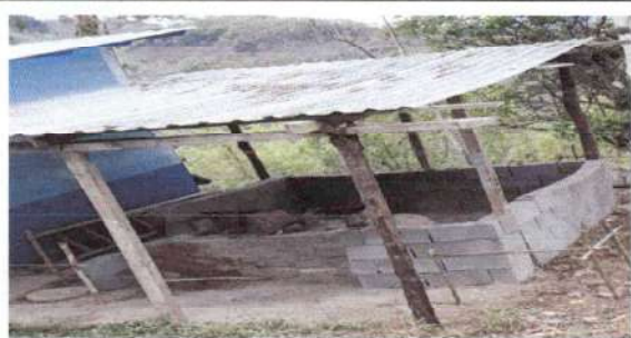
Foto 3: SUSTITUCIÓN DE LÁMINA
