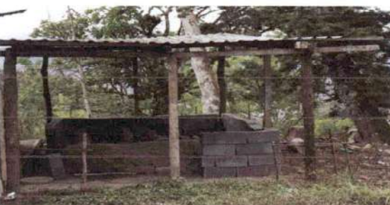
Foto 6: SEGUIMIENTO DE MURO
