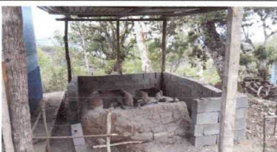
Foto 4: SUSTITUCIÓN DE ESTUFA
