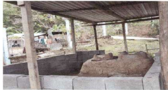
Foto 2: SEGUIMIENTO DE MURO
