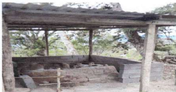
Foto 1: SUSTITUCIÓN DE PISO
