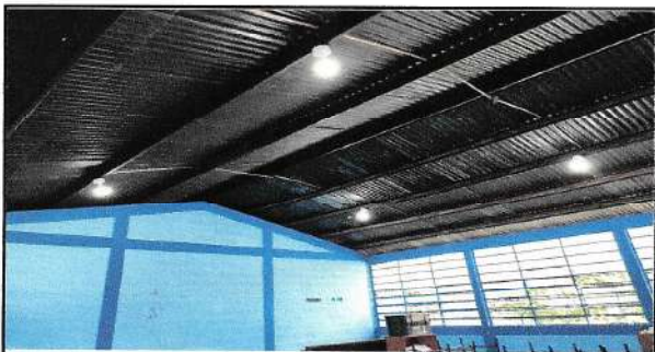
Foto 9: Sustitución de sistema eléctrico
