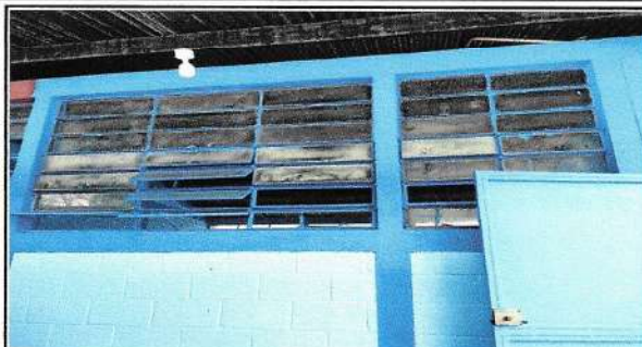
Foto 2: Sustitución de vidrio
