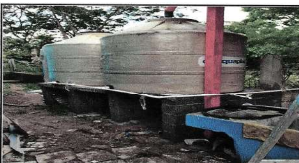
Foto 10: Reparación base de deposito de agua y compra de tinaco
