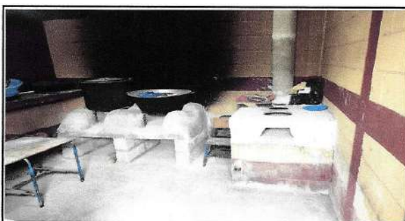
Foto 4: Reparación de cocina
