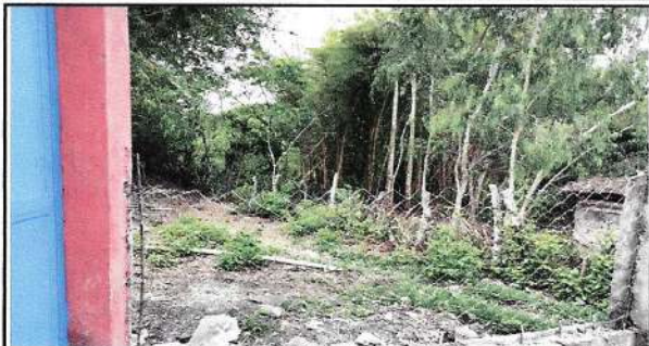
Foto 1: Reparación muro perimetral
