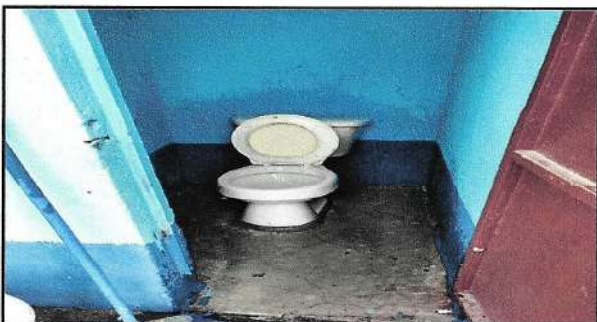
Foto 3: Reparación de servicios sanitarios
