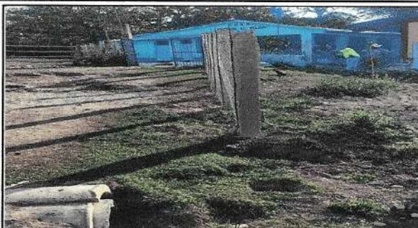
Foto 8: Sustitución de poste de madera por poste de concreto.
