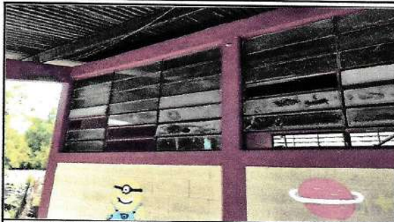
Foto 2: Sustitución de vidrio
