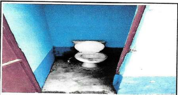
Foto 3: Reparación de servicios sanitarios
