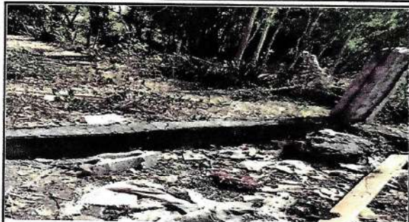
Foto 1: Reparación muro perimetral
